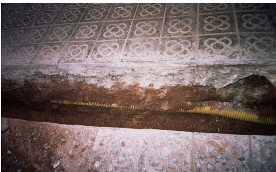
F.8 Rasa 4000 amb presència del cablejat de l'enllumenat del carrer. C/ Torres i Amat .
