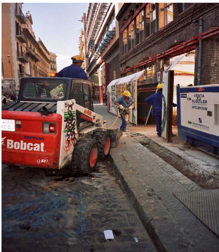
F. 3 Rasa 2000. C/ Torres i Amat. Procés de treball amb martell pneumàtic.
